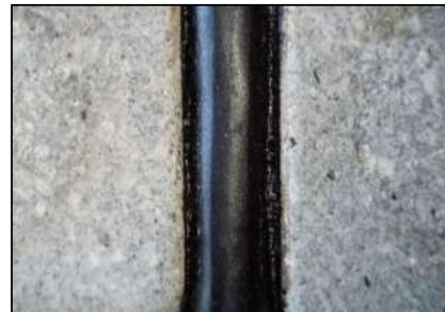
RTT Sealant Liquid Pour application
